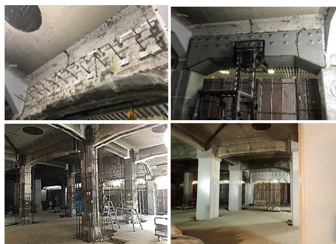
図-4. 鋼板巻き補強（上：梁部 下：柱部）
