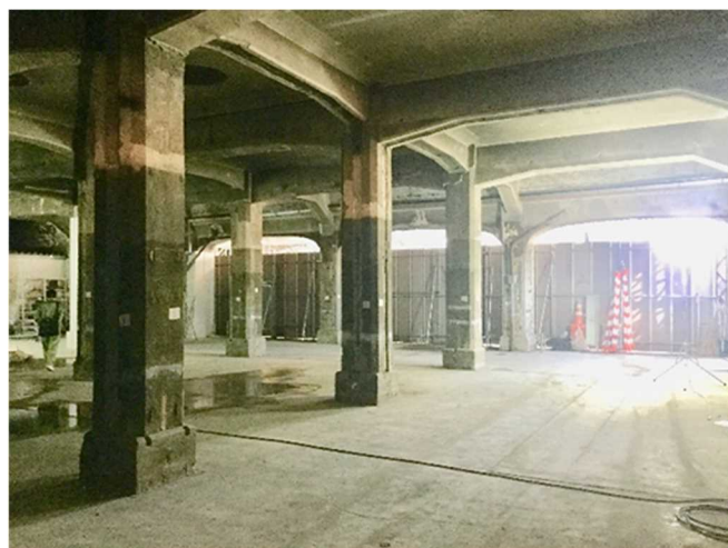
図-3. 化粧撤去後の既存高架橋
