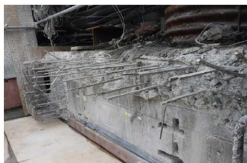
写真1 既設コンクリート切り状況（品川方）
