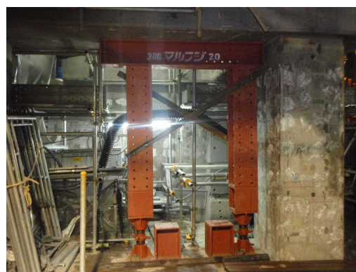
写真2 上層横梁支保工（新宿方）
