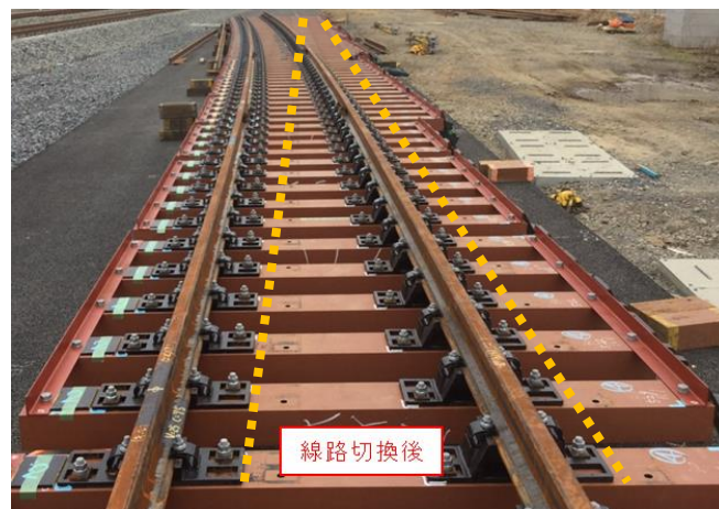
写真2 仮組試験（切換口A線路切換後）
