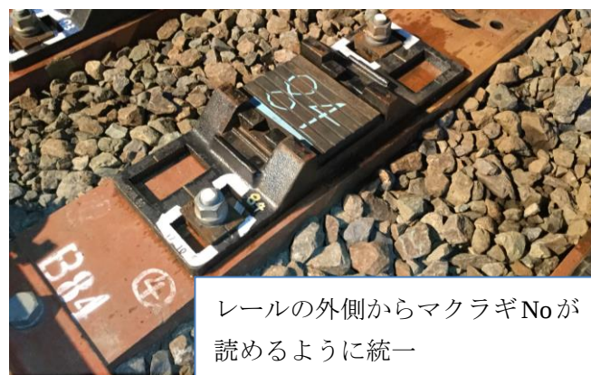
写真3 締結装置の印付け
