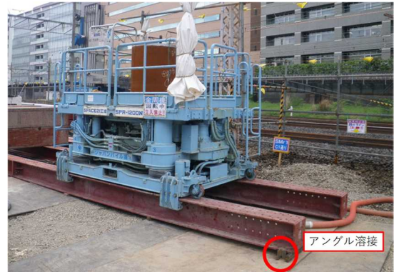
写真-2 杭打機セット状況
