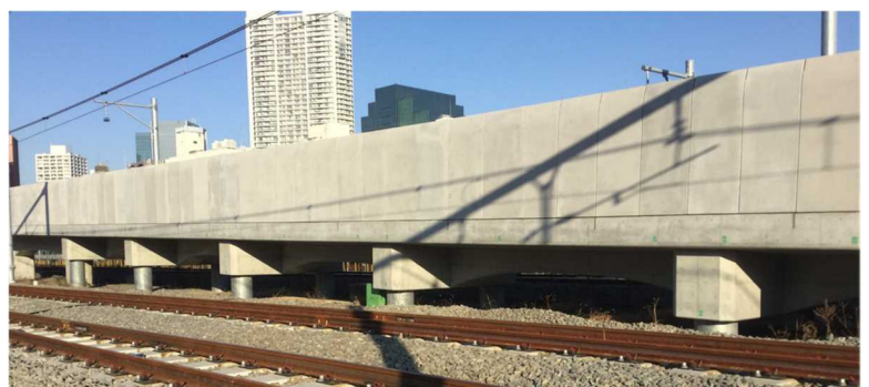
写真-3 低床高架橋完成写真
