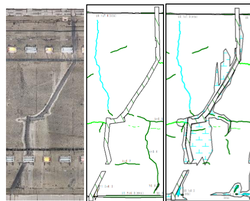
図-2 トンネル覆工の損傷例
