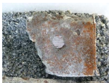
図-1. 散布した鉄粉の発錆の様子
