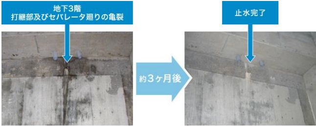
図1：BE 混和コンクリート止水の様子 1)
