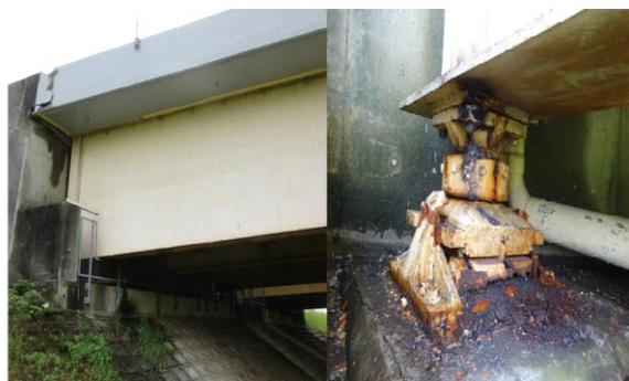
写真-1 緑川橋の支承の損傷状況
