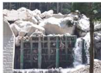
写真-1 透過型砂防堰堤
