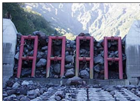
写真-1 鋼製透過型砂防堰堤
