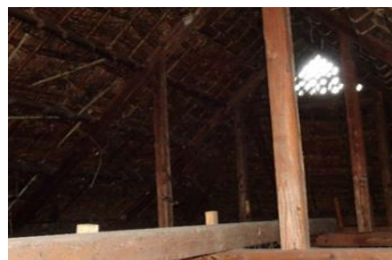
写真 2 小屋裏の状況
