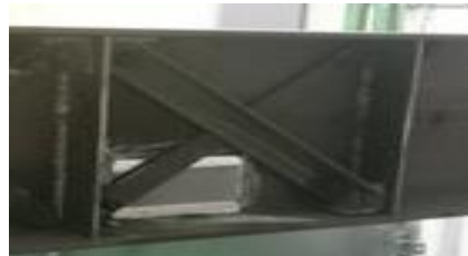
図3 トラス補強の概要
