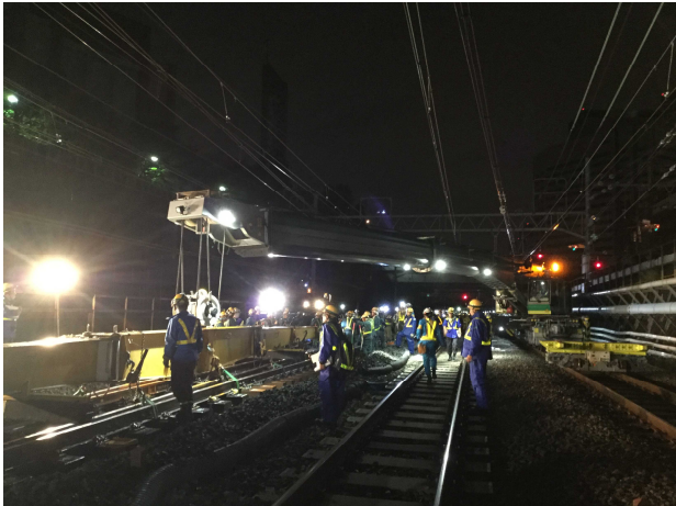
写真 2 鉄道クレーン車による分岐器敷設(71 イ号)
