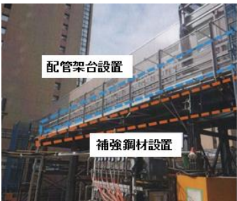
図-6 配管架台設置位置図
