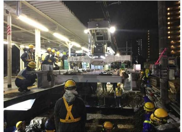
写真-2 鉄道クレーン車による工事桁架設
