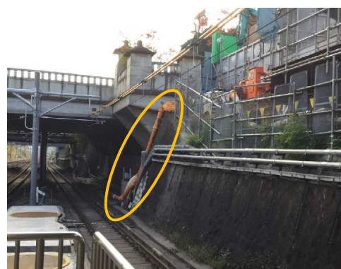
写真－１ 配管敷設
