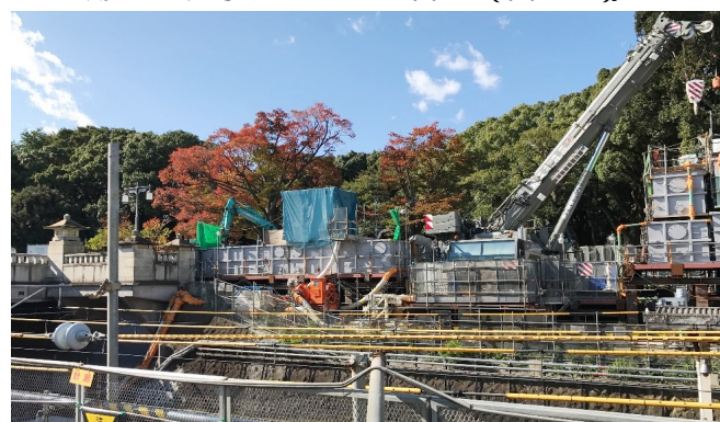
図-5 作業構台設置完了
