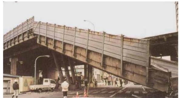
図-1 兵庫県南部地震での橋の被害
