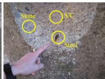
写真-3 削孔面の状態
