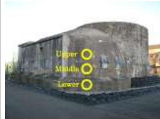
写真-6 観測所外壁測定面
