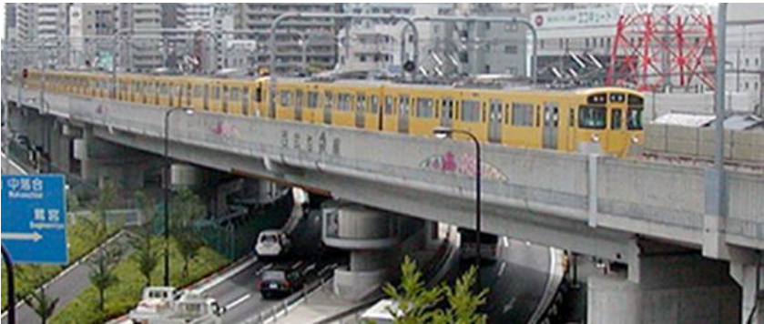
図 2 既に完成している立体交差区間の様子
