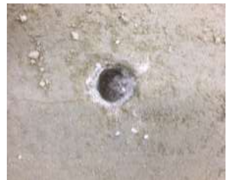
写真-2 再載荷後のCASE4の地盤表層
