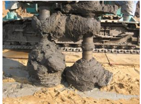
図-1 実施工で共回りを起こした際の攪拌翼の様子
