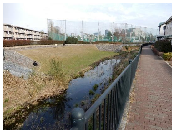
図-6 東伏見護岸の緩傾斜部分
