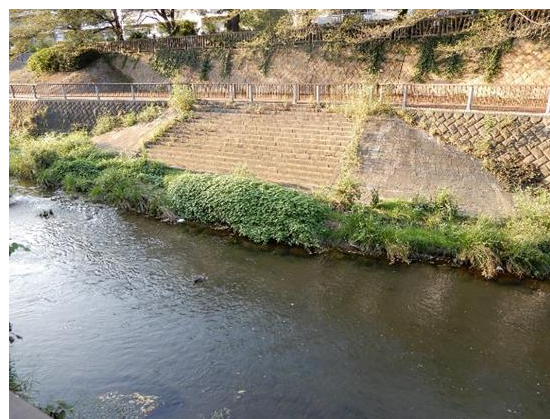
図-5 南田中護岸の緩傾斜部分
