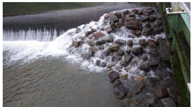
写真13 越流水深が10cm程度の流況
