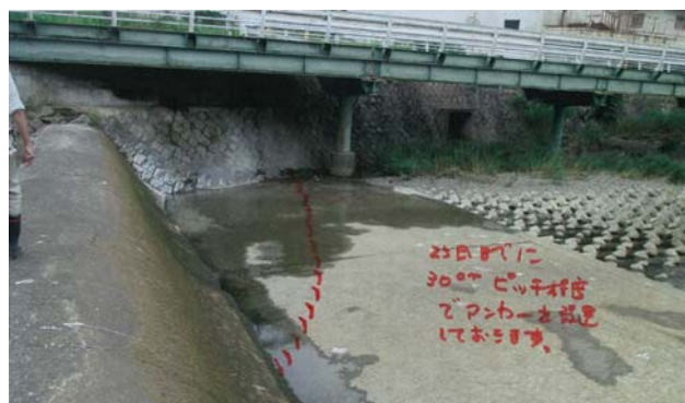
b) 左岸側の石組み設置予定範囲
