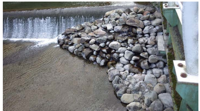
写真14 越流水深が5cm程度の流況
