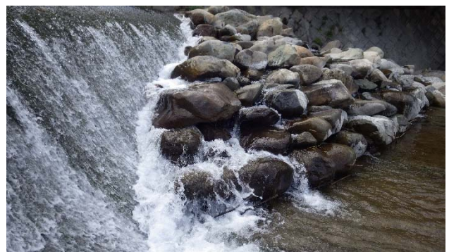
写真15 越流水深5cm程度の越流面境界近くの流れ
