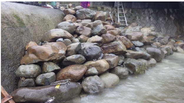
写真11 石組み施工完了時の状況
