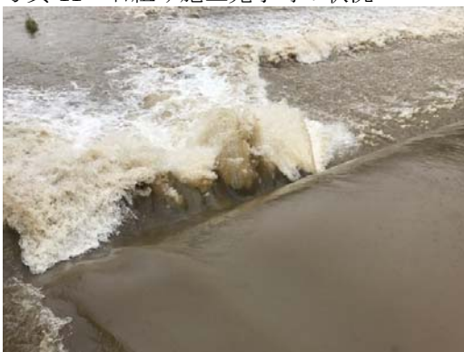
写真12 中規模の出水の状態(越流水深40-50cm)
