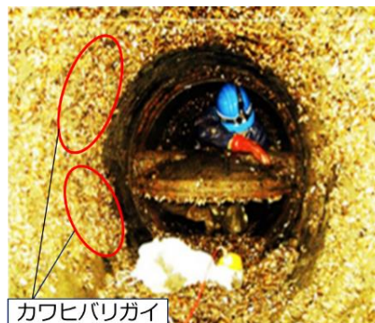
写真-1 導水管内のカワヒバリガイの付着状況の例 3)
