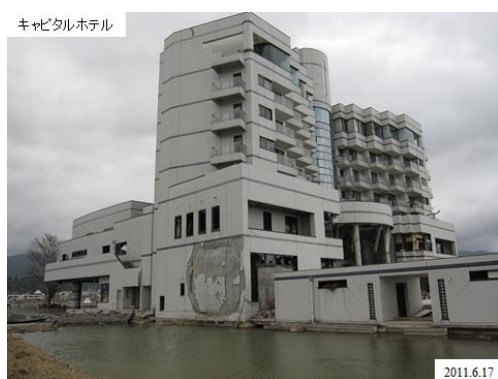
図1 1階部分が水没し、津波の水圧で壁がはらみ出したキャピタルホテル
