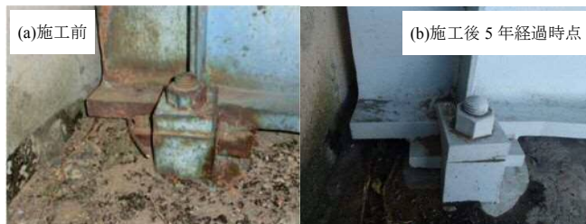
写真-2 桁端部の塗替え前後の状況
