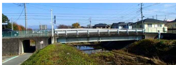
写真-1 橋梁全景
