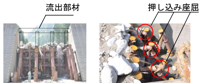
(a) 正面図 (b) 水平部材圧縮状況
