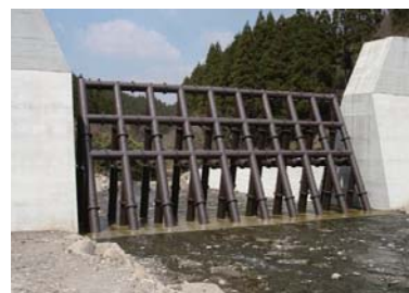
写真-1 鋼製透過型砂防堰堤
