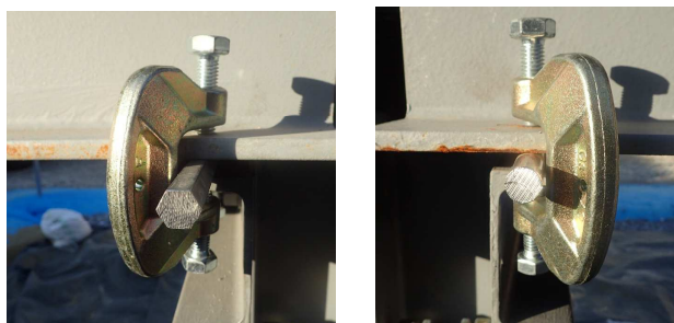
図4 桁の固定(左:起点側, 右:終点側)
