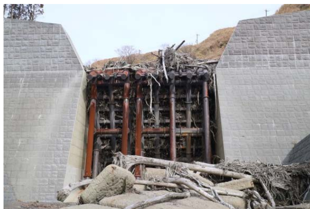
写真-1 鋼製砂防堰堤
