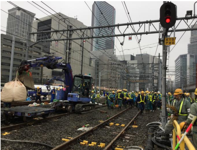
写真 1 基地部起点方の施工状況
