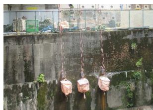
図-7 仮排水パイプ設置状況
