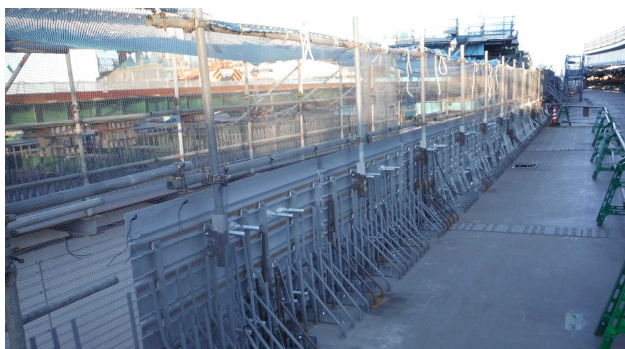
写真-2 埋設型枠内に設置した線路防護網
