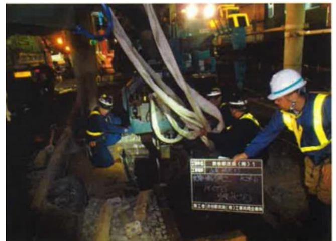
図11 パイプロによる H 鋼引抜状況写真
