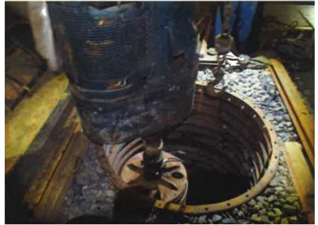
図9 ケーシングによる H 鋼引抜状況写真
