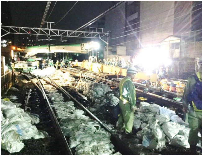
写真－3 隣々接線からの分岐器挿入
