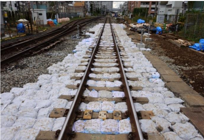
写真－1 バラスト袋詰めの様子
