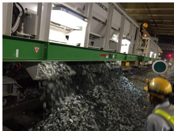
写真-2 ミニホキ車によるバラスト散布
