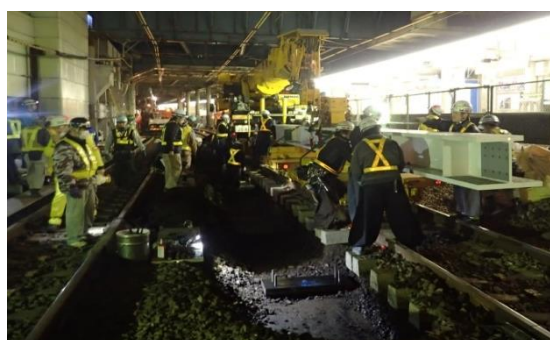
図-5 埼京下り線主桁架設状況 (50t軌陸クレーン)
