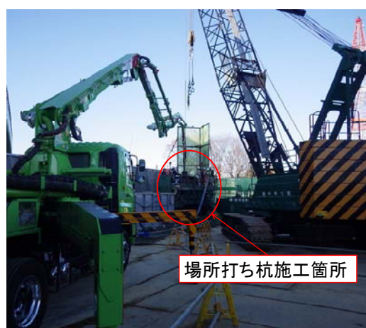
写真-1 施工状況
