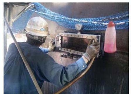
図-6 真空検査(溶接部)
