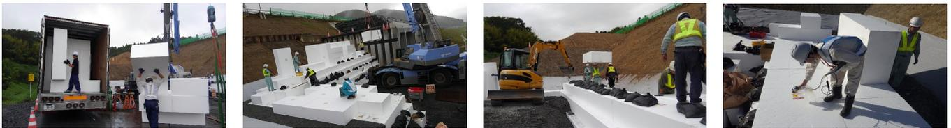
(a)EPS ブロック搬入 (b)クレーン吊上げ・仮置き (c)EPS ブロック設置 (d)QR コード読み取り状況
