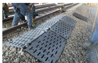
写真-2 プレート連結状態
