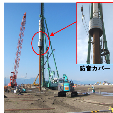
写真 3 杭打機及び防音カバー
