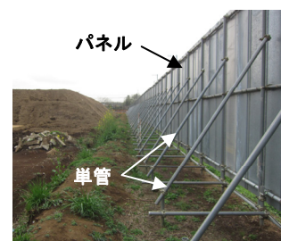
写真1 仮設防音対策の例 (単管の骨組+パネル)
