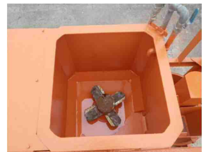
写真-2 角型みキサ内部
