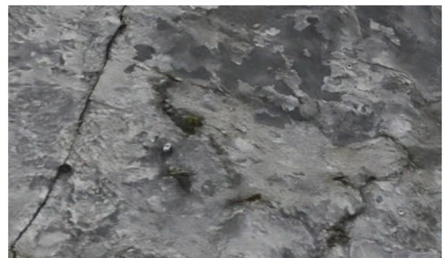
写真-4 オルソフォト画像(吹付表面拡大)/UAV撮影
