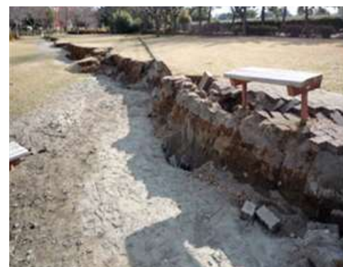
写真 1 東北地方太平洋沖地震被害
