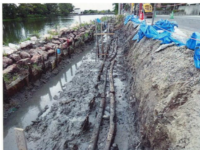
写真-7 佐賀城の内堀基礎構造
