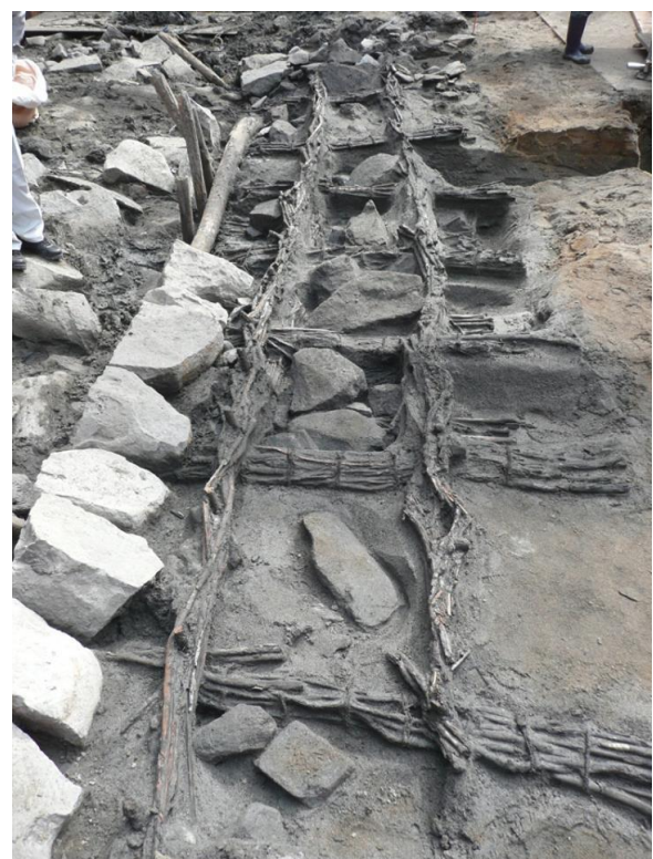
写真-3 デレーケ導流堤基礎（粗朶工法） 2)
