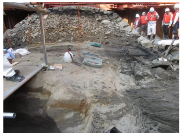
写真-2 デレーケ導流堤（断面） 2)
