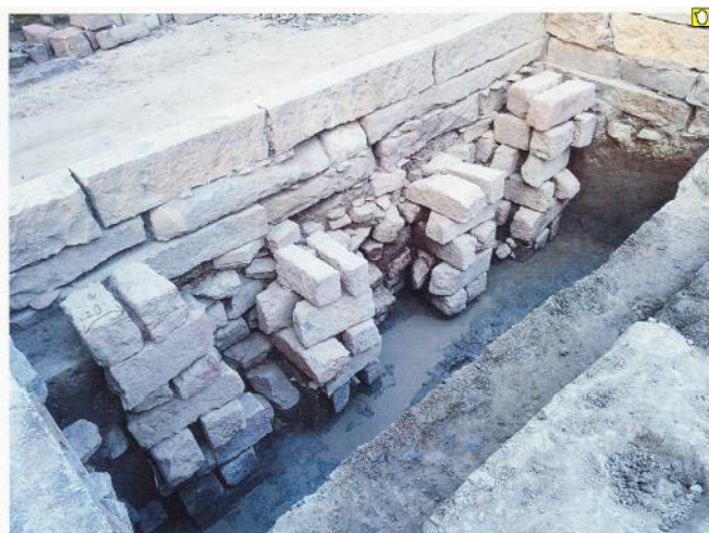
写真-4 新北神社拝殿礎石の基礎 2)
