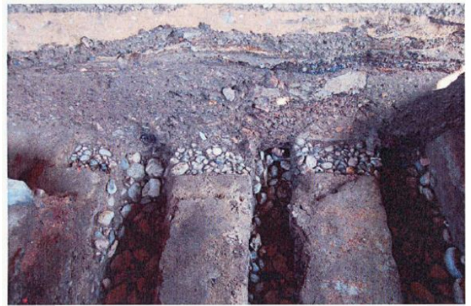
写真-9 多布施反射炉の基礎構造 2)
