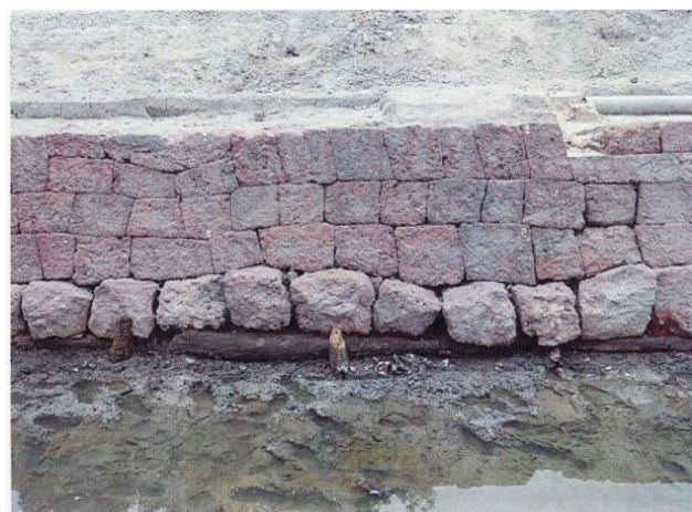
写真-8 佐賀城の内堀基礎構造
