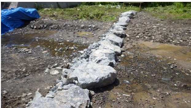
写真2(b) パンケ平取川に設置された治山堰堤下流側の石組みによる減勢工の施工状況
