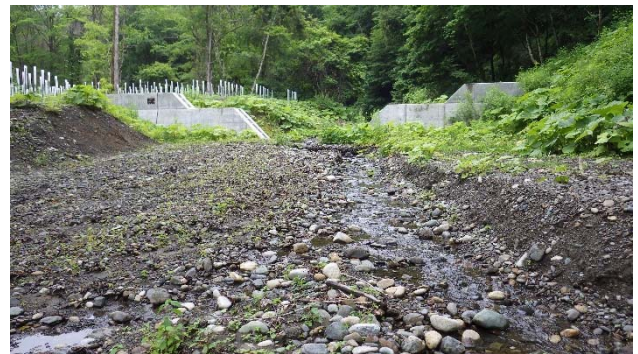
写真3 布団かごによる減勢工の出水後の状況
