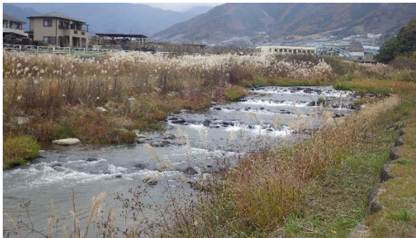
写真1 石組みによる魚道工
