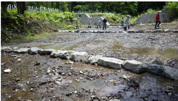
写真2(a) 石組みによる減勢工の施工状況
