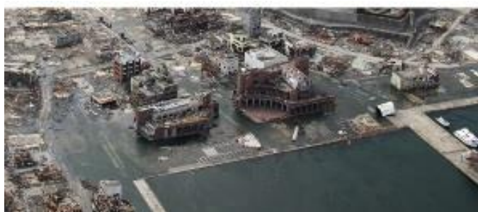
図-1 マリナル女川付近の被災状況 1)
