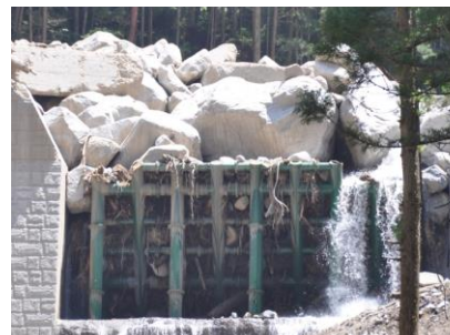
写真-1 巨礫の捕捉状況
